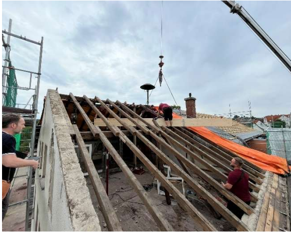
Abb. 5: Zimmerarbeiten Dachgeschoss (September 2025)
