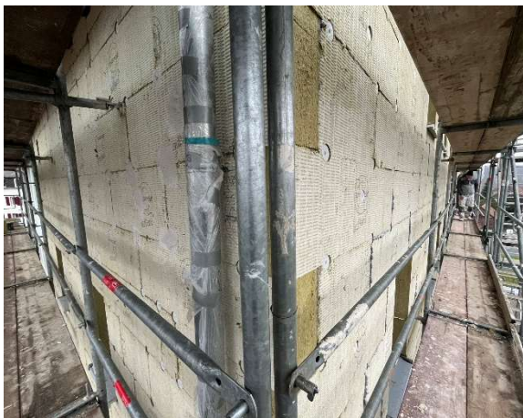
Abb. 7: Wärmedämmverbundsystem (Dezember 2025)
